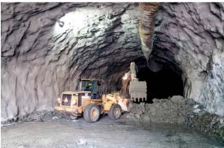
Figura 5. Excavación del túnel San Antonio.
