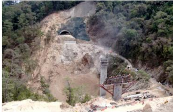
Figura 7. Viaducto Oaxaca y portal sur del túnel San Sebastián.
