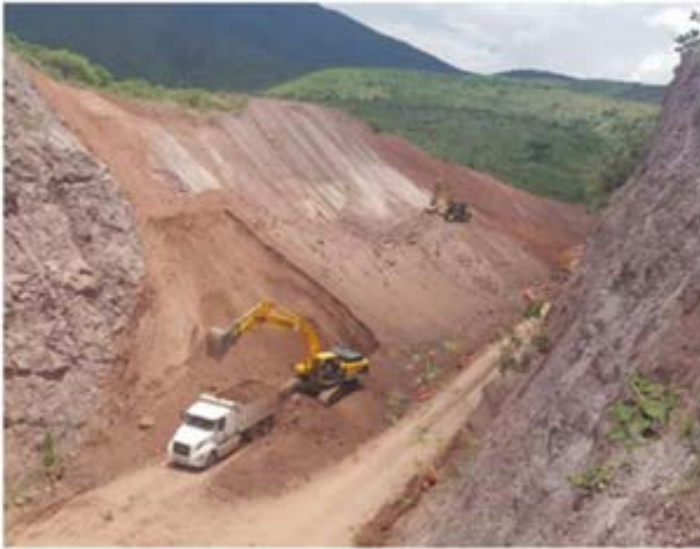
Figura 2. Excavación de corte y tipo de material.
